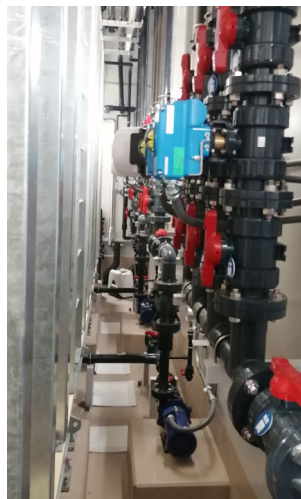
実験排水貯留槽や配管を更新。点検 が容易となり、実験排水の漏洩管理を 強化しました。
