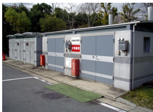
廃液保管庫 (物質創成科学棟南側)
