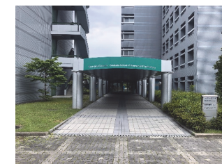
[バイオサイエンス棟]
