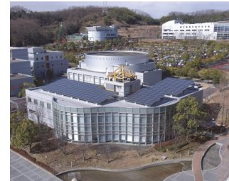
既設太陽光発電設備（大学会館）
