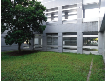
空地となっている研究棟の中庭
